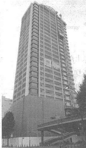
建設が進む「栄タワーヒルズ」と、公開された26階からの眺望（西側）
