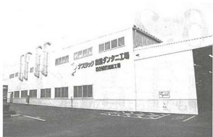
木製品製造の生産ラインを改良したナスラック 出雲ダントニ工場＝出雲市長浜町
